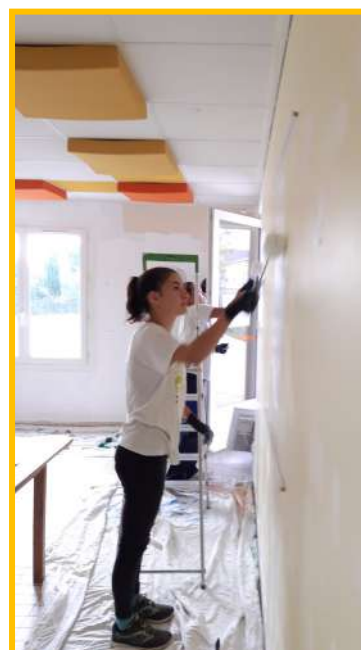
Peinture au restaurant scolaire
